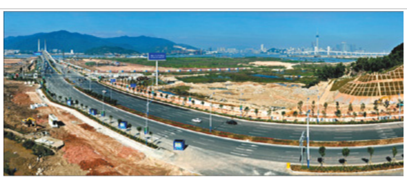
由中冷集团总承包建设的广东珠海横琴岛市政基础设施及地下综合管廊项目。 资料图片
