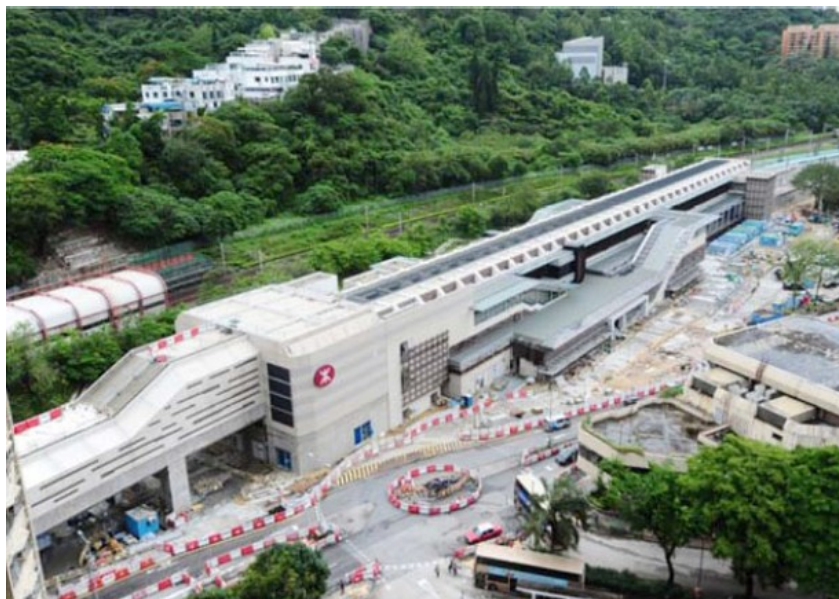
沙中線「東西走廊」已完成89%工程。(港鐵提供)
